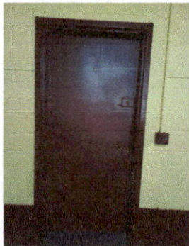
Foto 5: Cambio de chapas en puertas
