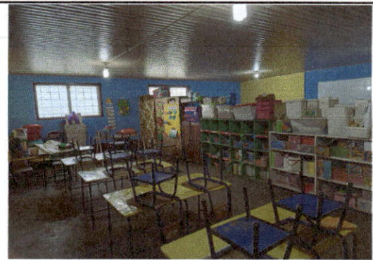
Foto 4: Colocación de cielo falso de PVC
