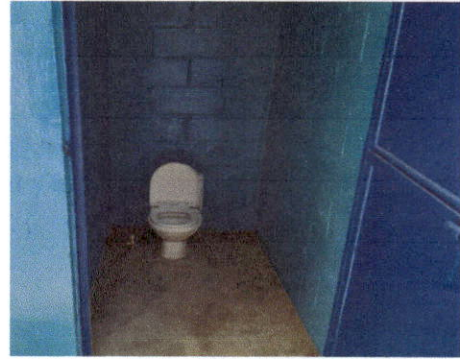
Foto 2: Sustitución de accesorios de baños
