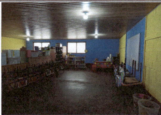
Foto 3: Colocación de cielo falso de PVC
