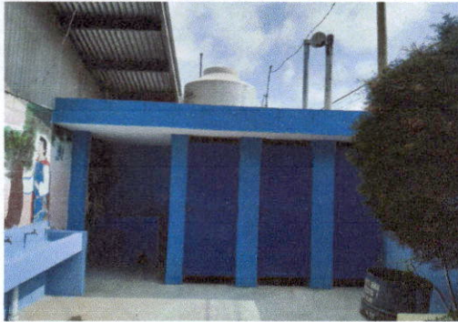
Foto1: Cambio de lamina por losa en modulo de baños.
